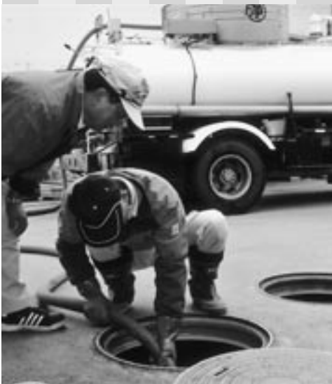
浄化槽清掃作業風景
